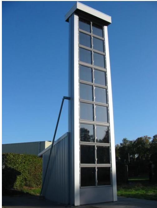
Figuur 7 – Test mock-up Solar Chimney
