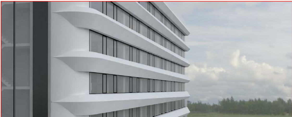
Figuur 3 - Ventilatiekanalen als architecturale expressie (ontwerp Peter Swier 2016)
