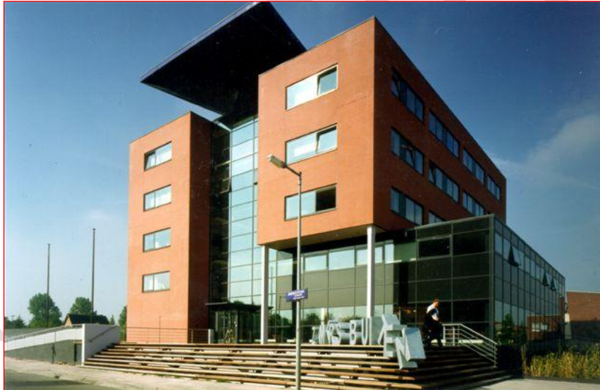
Figuur 7.2.1/1 - Kantoorgebouw Zomers Buiten Amsterdam
